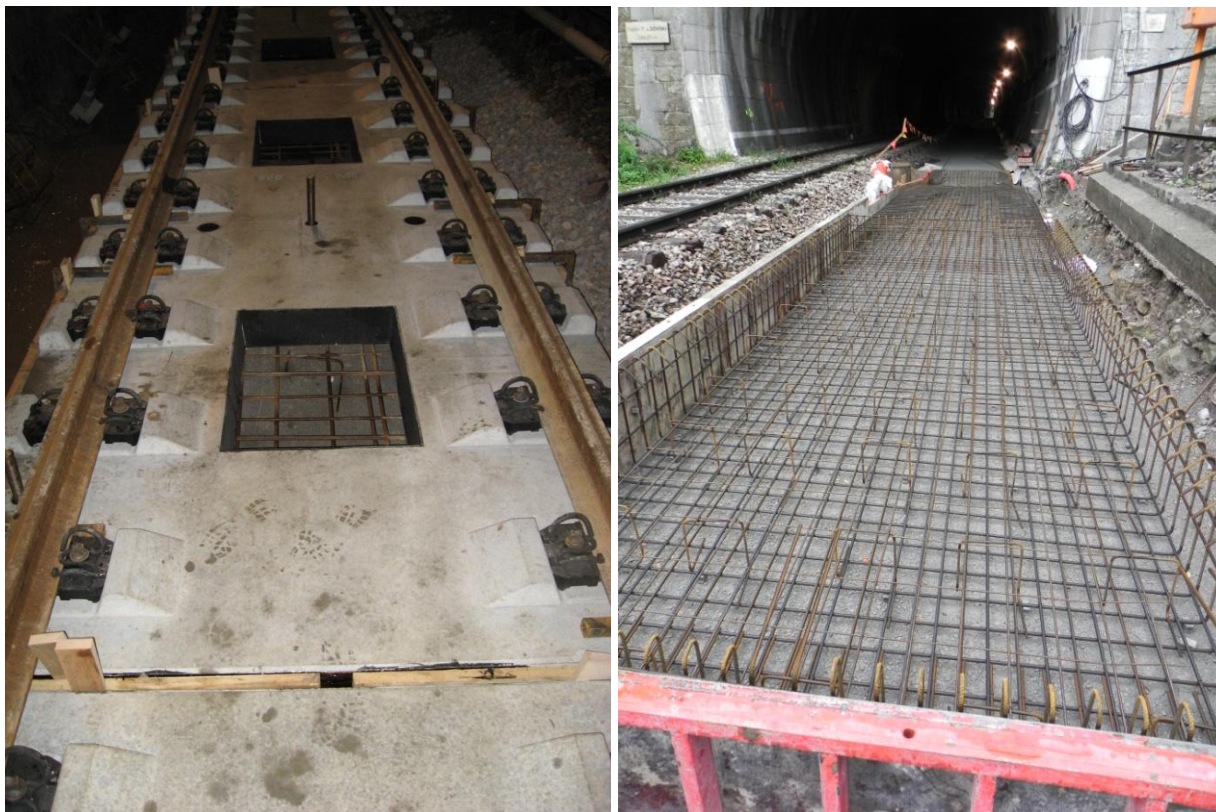
Slika 3: ÖBB-PORR plošče po vgradnji v predoru Križiški in betonska plošča (vir ZRMK)
