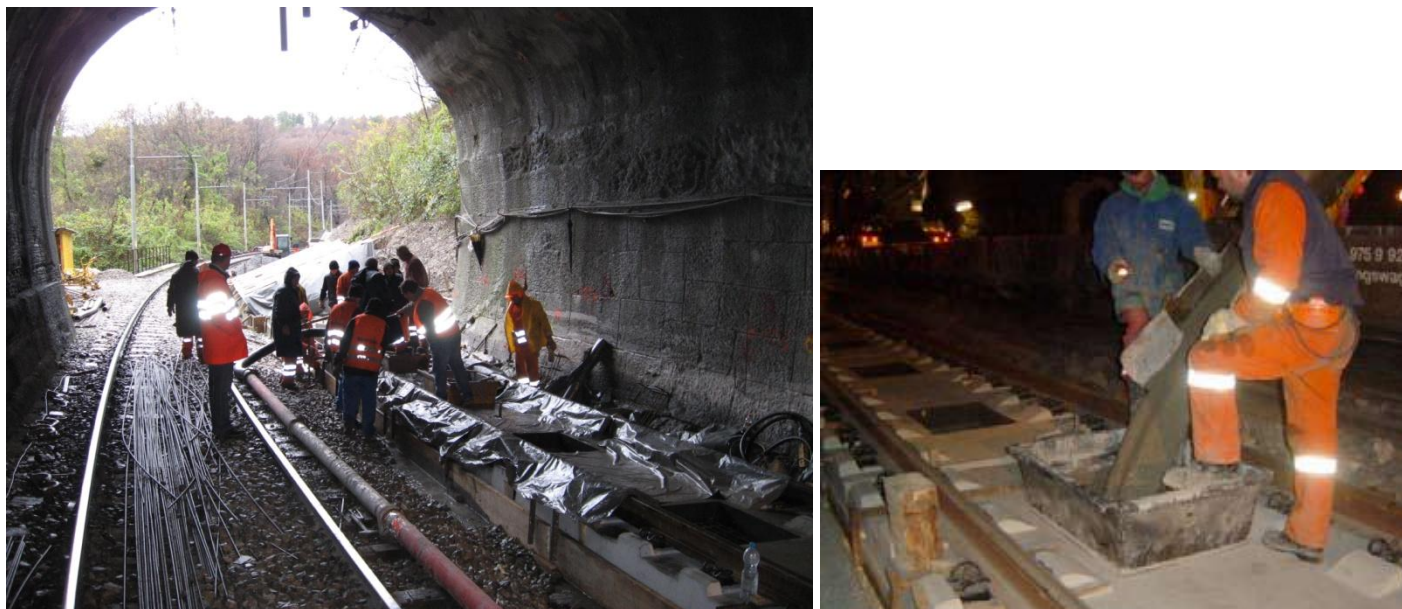
Slika 5: Vgrajevanje samozgoščevalnega podlivnega betona na gradbišču v predoru Križiški (vir ZRMK, ÖBB-PORR)
