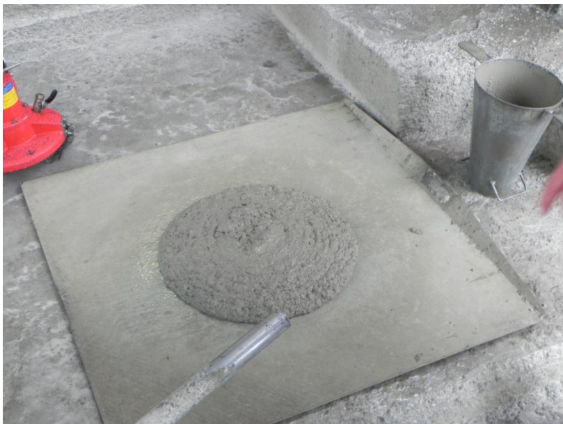
Slika 4: Preverjanje konsistence samozgoščevalnega podlivnega betona na gradbišču v predoru Križiški (vir ZRMK)
