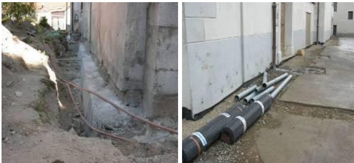
Slika 7: Sanacija temeljenja objekta (injektiranje ter dobetoniranje temeljev, prenova sistema metorne kanalizacije)
