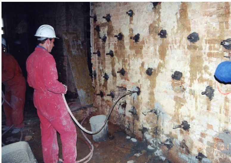
Gimnazija Kočevje – mešan kamnito opečni zid je primerno “namočen”
