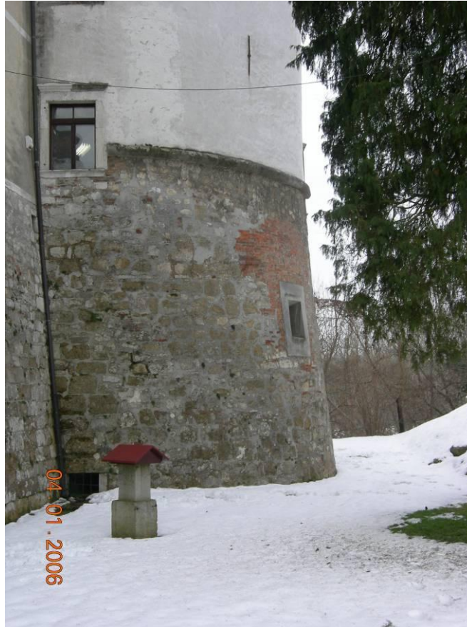
Grad Brežice – kamniti zid z vložki opeke
