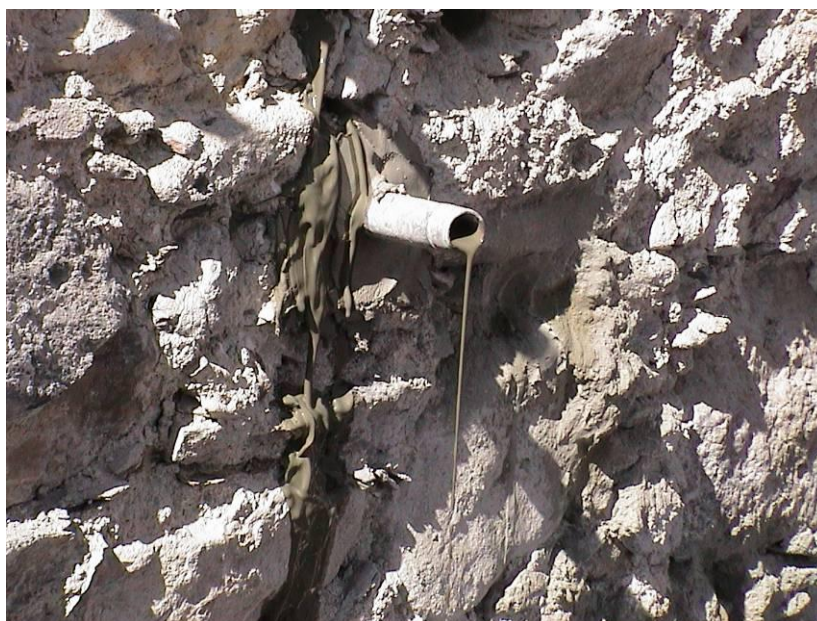
Injekcijska masa se pomika po zidu navzgor in izteka iz nastavkov
