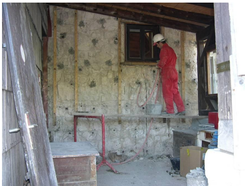
Planinski dom Komna – spodnji del zidu je zapolnjen in cevke odstranjene
