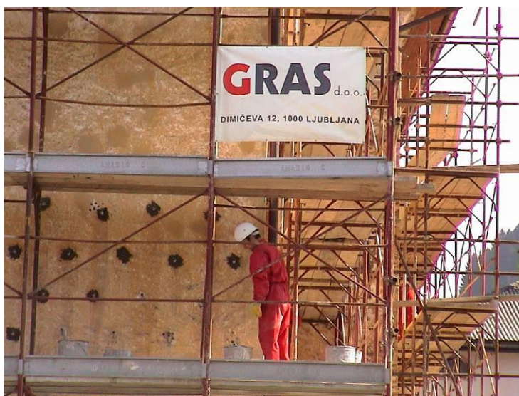
Cerkev Cerkno – vgradnja nastavkov
