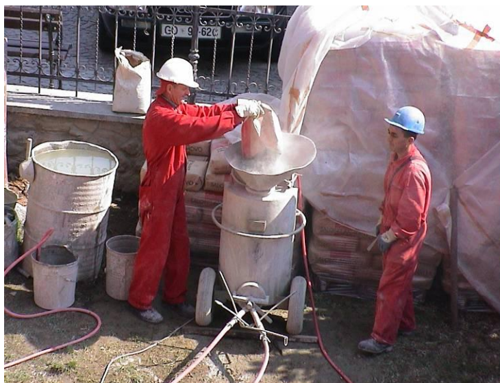
Priprava injekcijske mase na gradbišču
