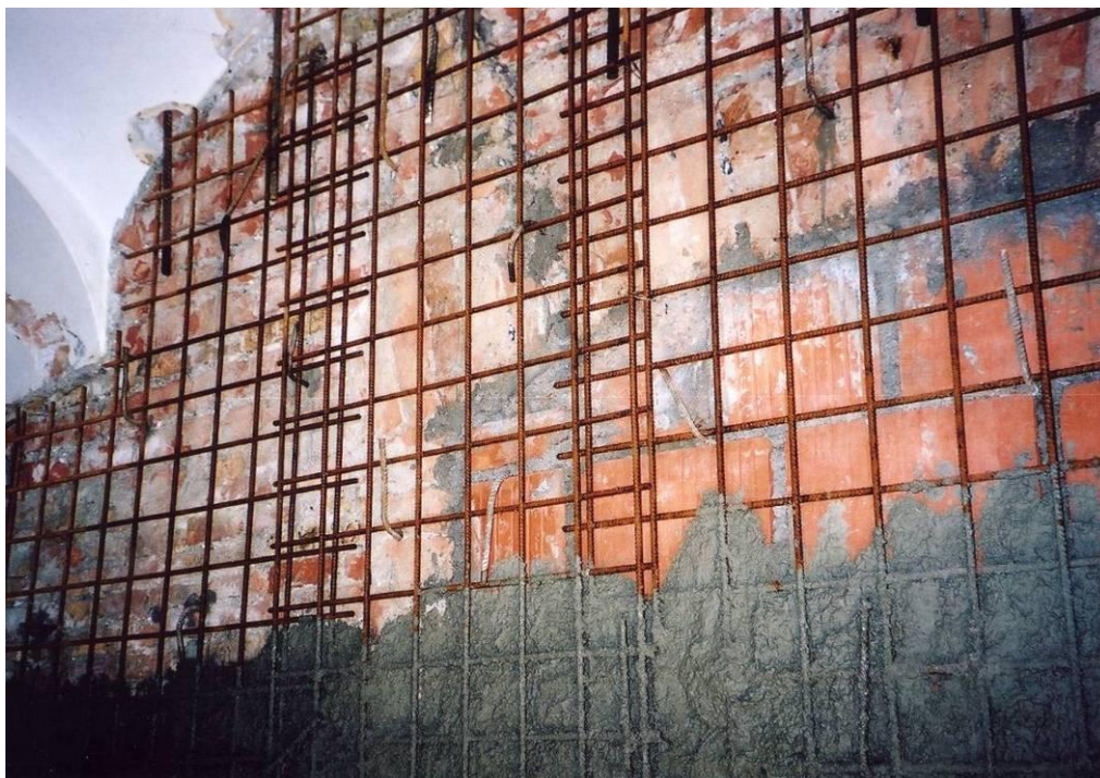
Slika 4: Izvedba obojestranskih armiranih ometov opečnih zidov
