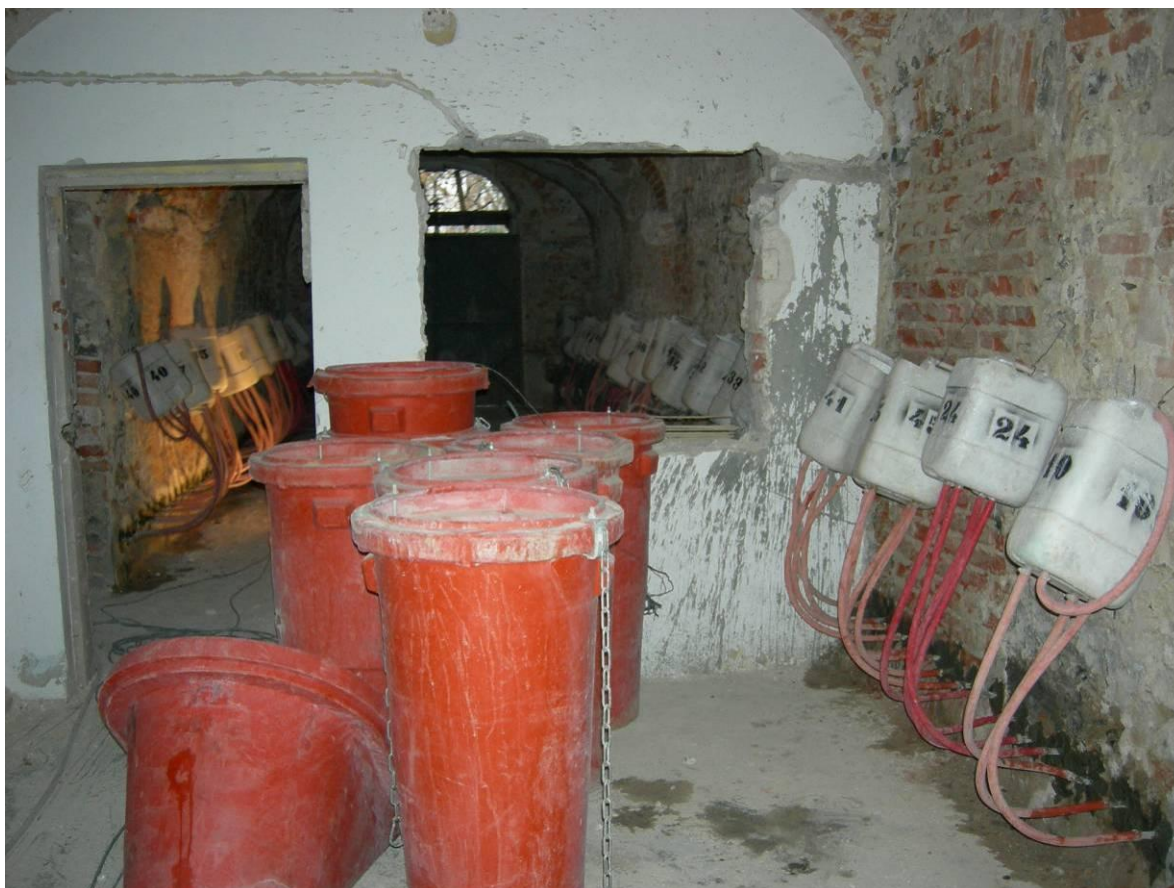
Slika 10: Izvedba hidrofobne bariere z raztopino silikonov
