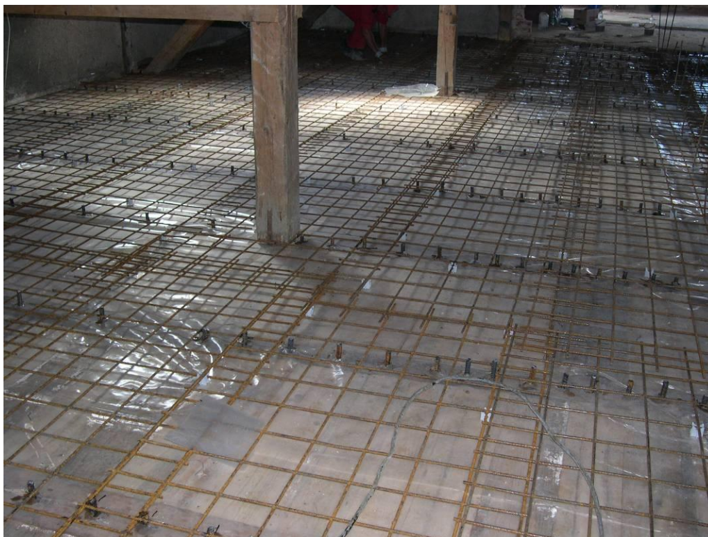
Slika 6: Izvedba armiranobetonskega sovprežnega estriha: opaž med stropniki, folija, armaturne mreže, v stropnike vgrajeni mozniki, še distančniki, pa bo pripravljeno za betoniranje
