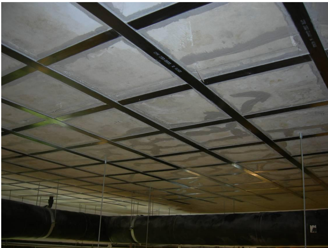
Slika 9: Povečanje nosilnosti armiranobetonske plošče s karbonskimi lamelami
