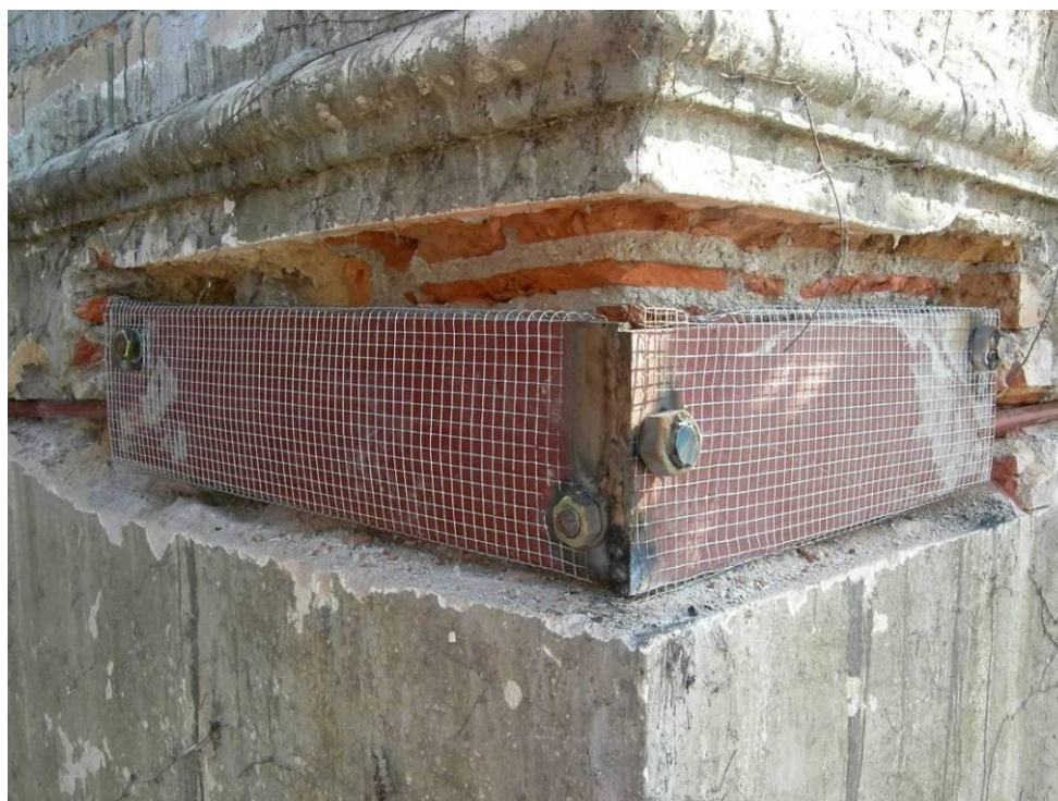
Slika 5: Izvedba protipotresnih zidnih vezi: sidrni plošči na vogalu sta rabitzirani za izvedbo ometa, matice so točkovno privarjene, vsi elementi pa so antikorozijsko zaščiteni
