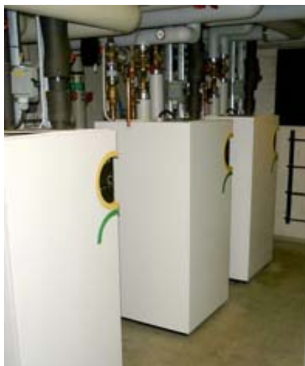
Slika C.5 TČ, ki izkoriščajo toploto izrabljenega zraka tekom hladnejšega dela leta, tekom toplejšega pa se izkoriščajo kot naprave za hlajenje prostorov (Vir: IVT heat pumps for larger buildings)
