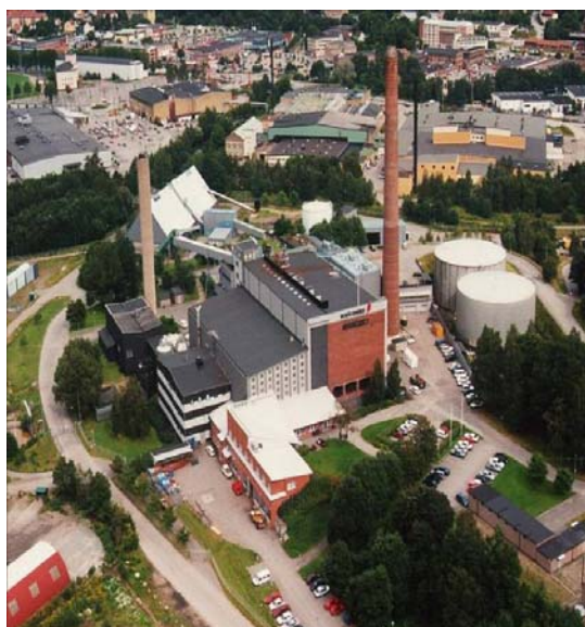
Slika C.6 Tovarna za soproizvodnjo toplote in elektrike na biomaso na Švedskem (Vir: Borås Energi & Miljö)
