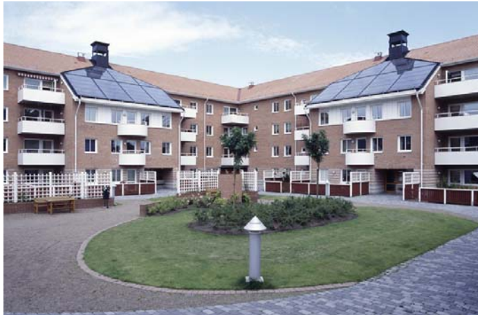
Figure C.1 Sončni kolektorji v stanovanjski stavbi, zgrajeni leta 2000 na Švedskem (Vir: Aquasol).
