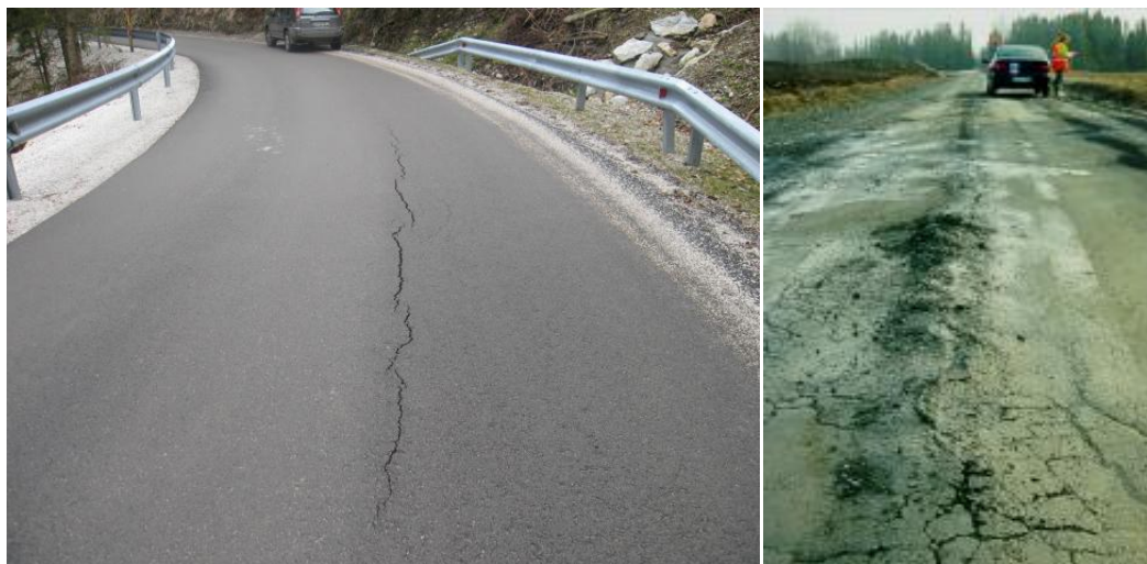
Slika 2: Tipične zmrzlinke poškodbe vozišča (dvigi)
