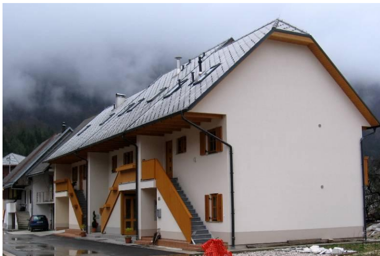
Slika 2 Nadomestne stavbe so pogosto lesene montažne izvedbe, vendar po izgledu sledijo tipični arhitekturi Posočja
