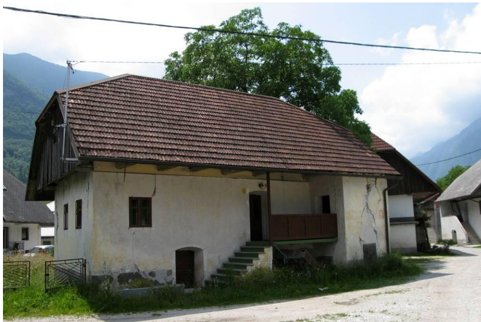
Slika 1 Tipična kamnita zidana stavba v Posočju
