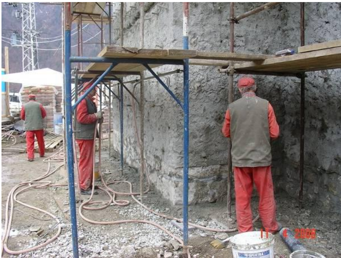
Slika 7 Primer utrjevanja kamnitih zidov z injektiranjem.
