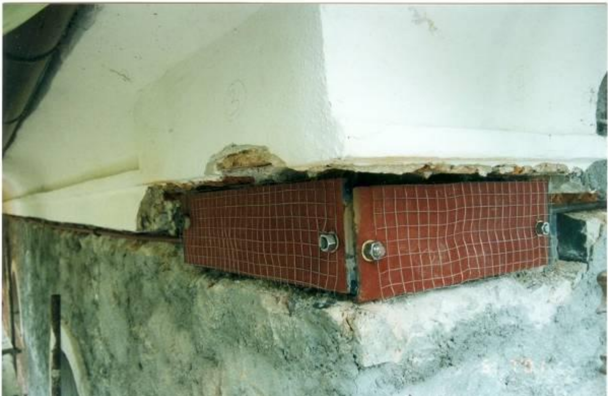
Slika 4 Povezovanje zidov z dvostranskimi jeklenimi vezmi – detajl vogala.
