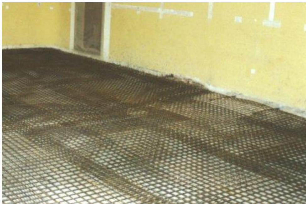
Slika 5 Primer vgradnje novih AB plošč.
