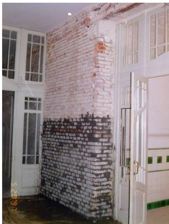
Slika 8 Primer izboljšanja karakteristik s prefigiranjem opečnega zidu.
