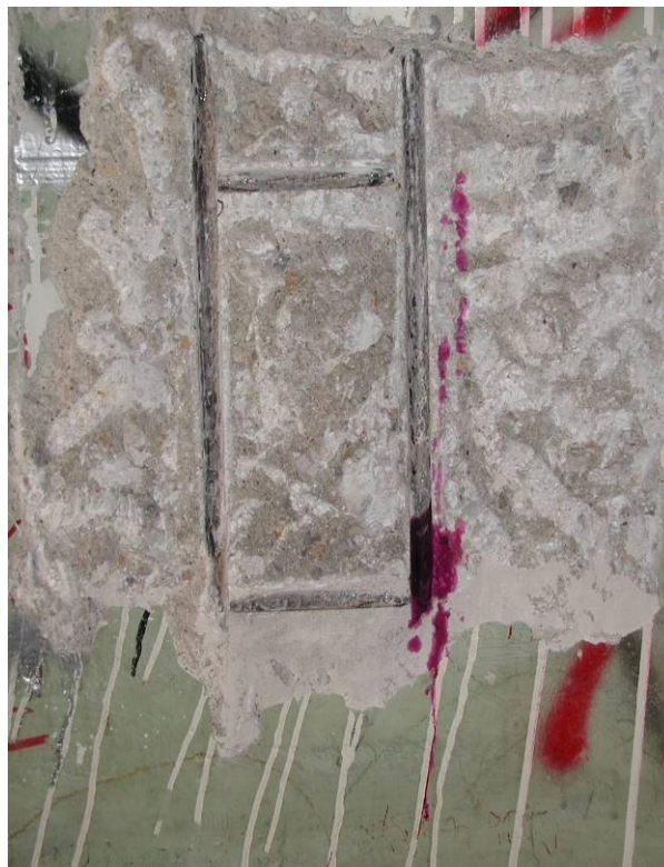
Destruktivne metode: iskanje količine in razporeditve armature
