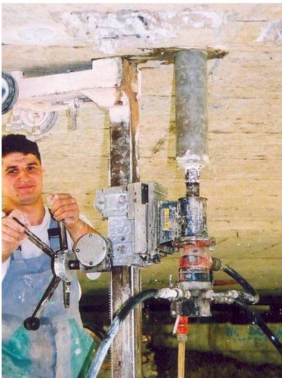
Destruktivne metode: vrtanje valjev iz betona za ugotavljanje lastnosti v laboratoriju
