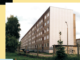
Stanovanjsko naselje Adolf-Bytzenk-Strasse, Eggessin, Nemčija
